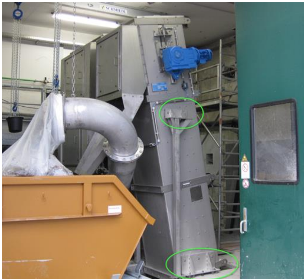
Ukázka kotvení česlí kolem montážního prostupu
