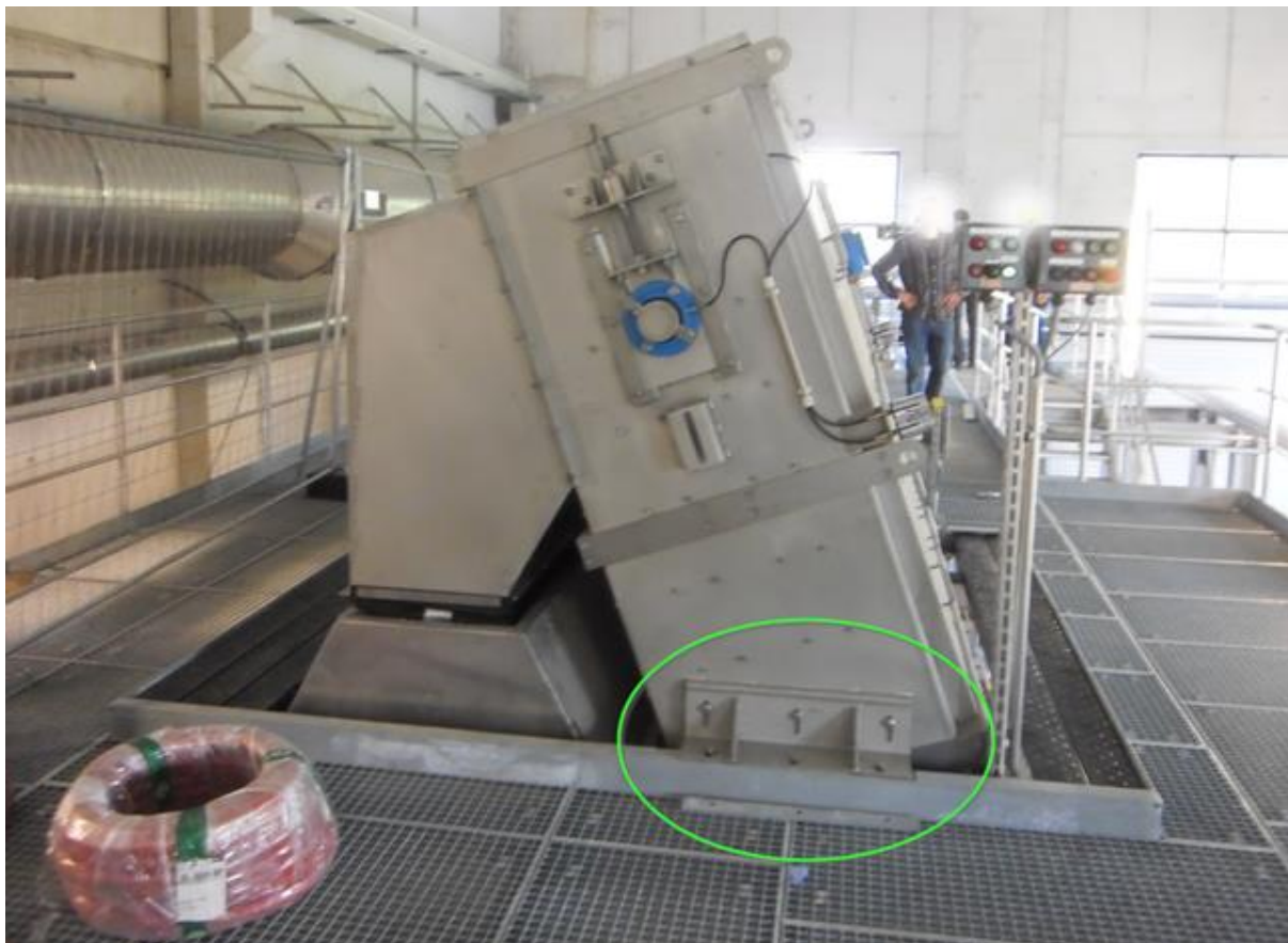
Ukázka kotvení česlí kolem montážního prostupu
