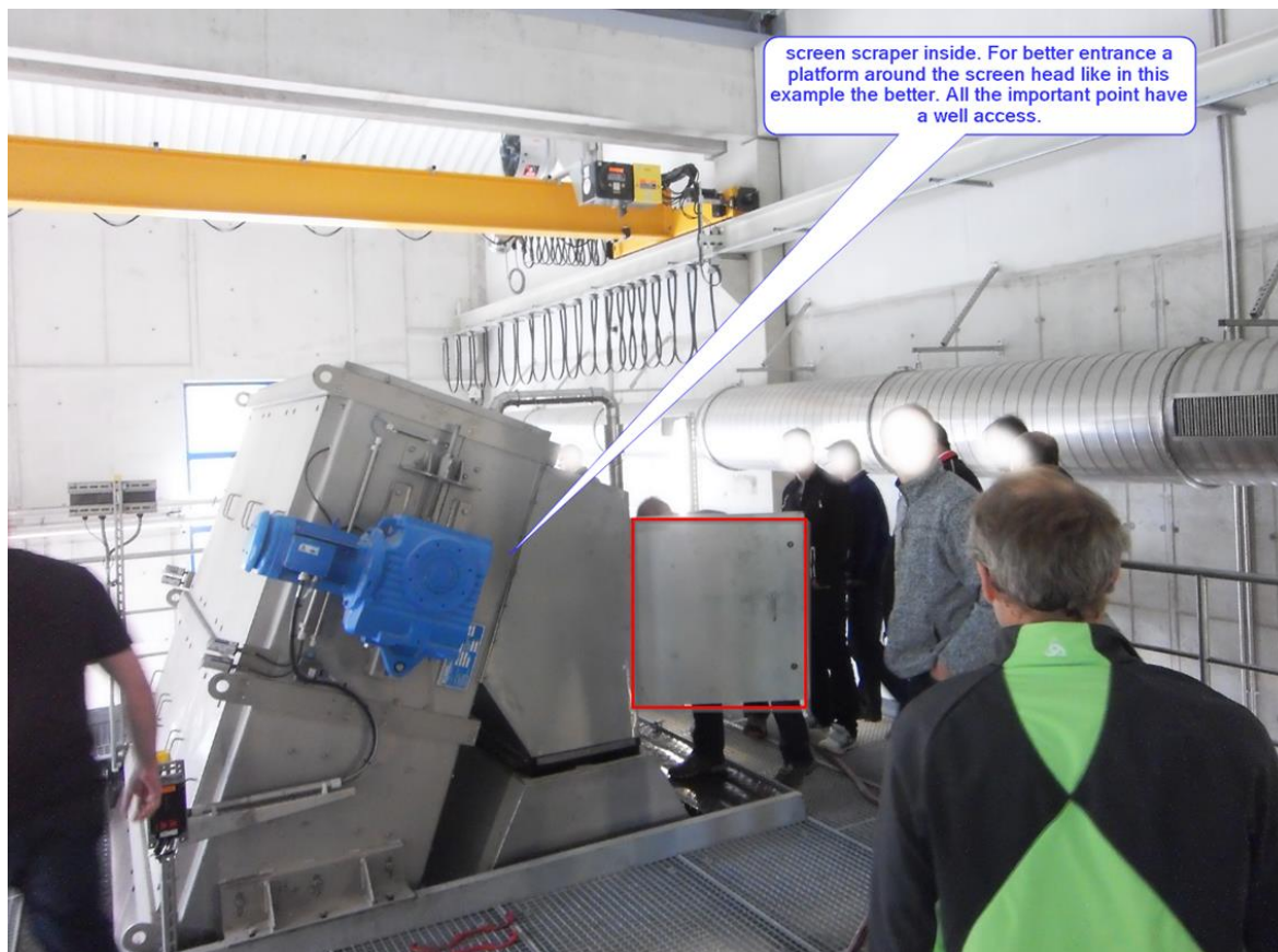
Ukázka otevírání čela česlí pro údržbu (červeně ohraničená část)
